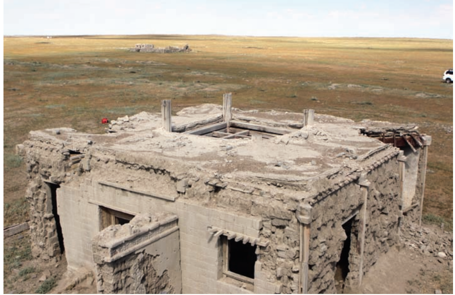
현재 매이다르 법당의 지붕 현황
