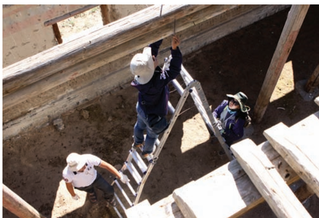
Доод давхрын дам нуруу болон баганын далбааны дээд талын банзны хийц бүтээцийн хэмжилт
