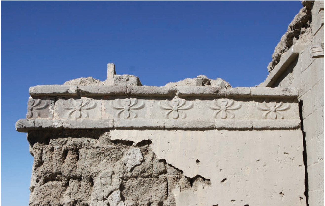
전실 외벽 상부 문양 전돌
