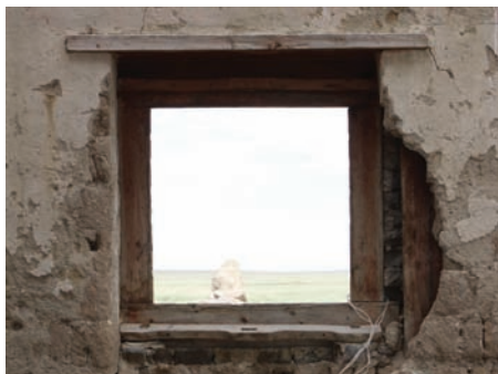
Углуурга нь үлдэж хоцорсон цонх (дотор тал)
