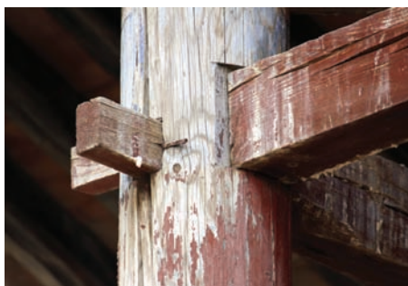
Гадна эгнээний өндөр багана ба төгсгөлийн жигүүрийн дам нурууны хоорондох ам зөрүүлсэн углуурга
