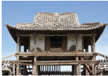
상층 중앙 출입문 외부 전경
